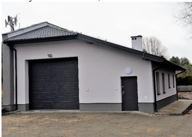
Nowy budynek remizy OSP w Czarnej.
