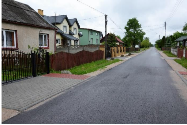
Droga w Grzybowie po remoncie.
