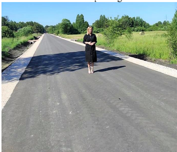
Droga Stąporków-Błaszaków po przebudowie.
