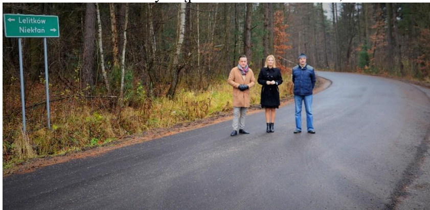
Droga powiatowa Niekłań-Furmanów-Lelitków, której remont współfinansowała Gmina.
