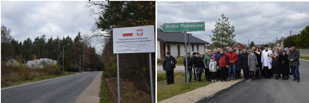
Droga powiatowa po remoncie, który współfinansowała Gmina.
