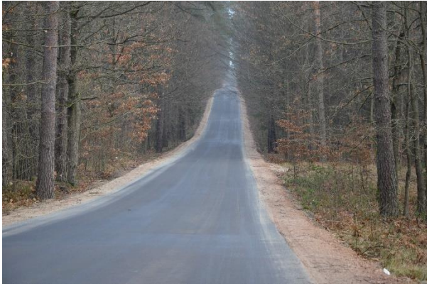
Droga powiatowa, której remont współfinansowała Gmina.
