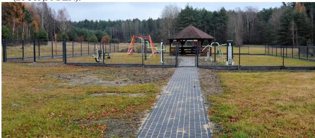
Plac zabaw w Kamiennej Woli po zakończeniu prac.
