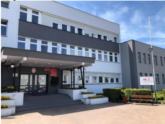
Elewacja zewnętrzna budynku Urzędu po odnowieniu.
