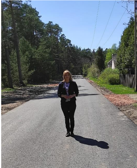
Droga gminna w Czarnieckiej Górze po przebudowie.
